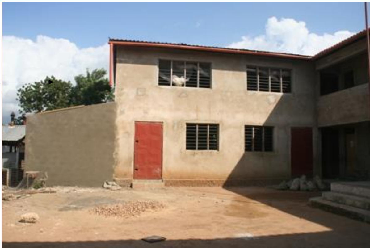
Nieuwe keuken in aanbouw
