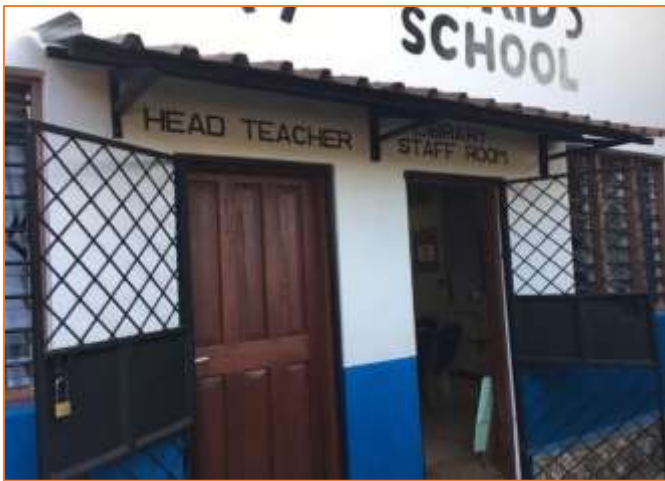
De ingang naar het bureel van Mr Barasa en de staff room werden verplaatst naar de voorkant van de school, juist onder het grote logo
